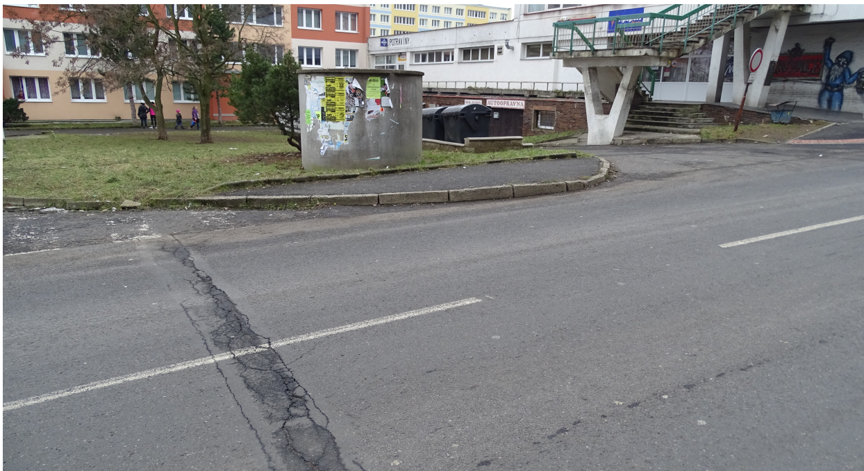
Obr. č. 1 – nedostatečné zhutnění po překopu sítí
